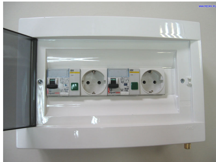
Рисунок 2 – Фотография щитка ЩС «Оптима» с УЗО с открытой крышкой
